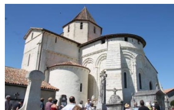
Eglise rénovée Reignac
